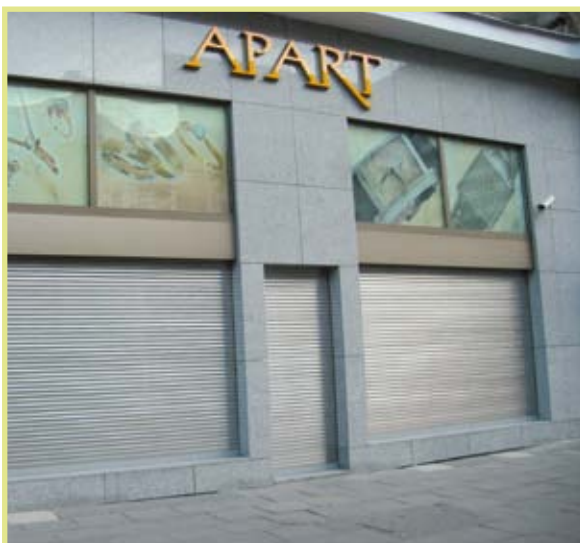
Schaufenster mit einbruchhemmenden Rollläden
